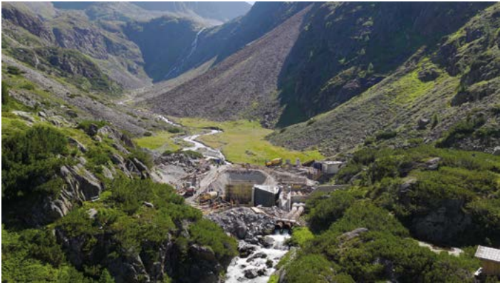
+ nach 15 km Transport durch den Beileitungsstollen erreicht man bei der Wasserfassung Winnebach das Tageslicht
