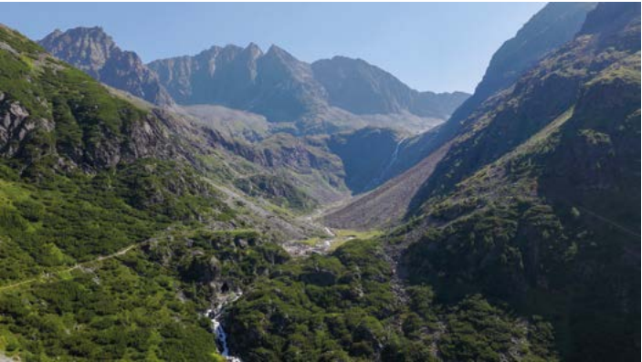
+ von der Ferne kaum zu erkennen – die Baustelle der Wasserfassung Winnebach im Vollbetrieb. Sie befindet sich oberhalb von Gries im Sulztal und wird nicht über das Tal, sondern vom Kühtai aus errichtet und versorgt.
