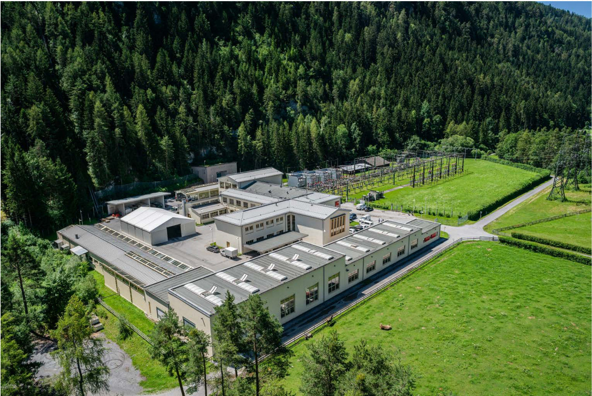
+ Blick auf die Betriebsgebäude des Kraftwerks Imst
